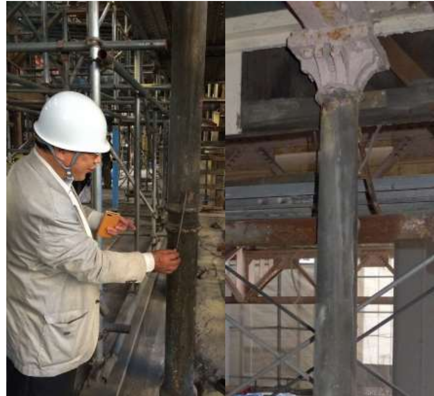
1914年(大正3年)1月作製の重要文化財門司港駅鑄鉄製支柱の再現
