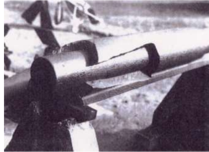
鑄鋼のスリーブを鑄鉄で鑄ぐるんだ大砲
