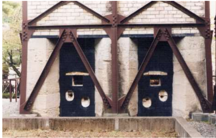
ほうこう 方孔(溶湯をかき混ぜるところ) 出滓口・出湯口
