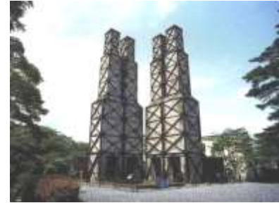
韮山反射炉建設
