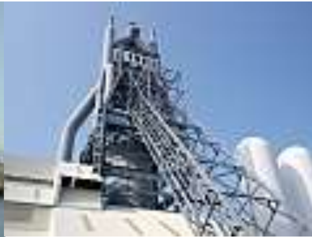
八幡製鉄東田第一高炉跡
